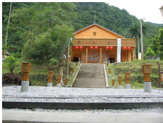
林田山-中山堂修復工程
