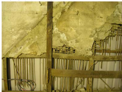
原有建築木摺灰泥牆
