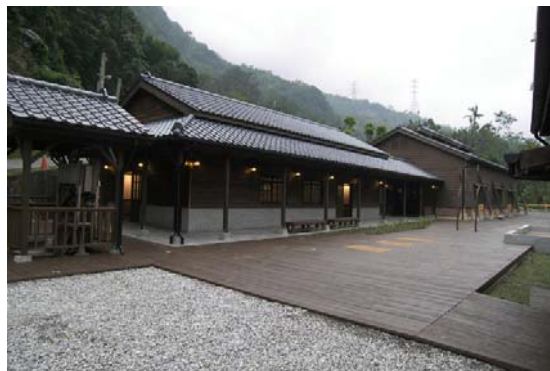
林田山-變電所修復工程
