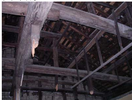
整修前屋頂木構架
